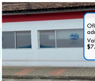
ADECUACIÓN BODEGA DEL METRO
